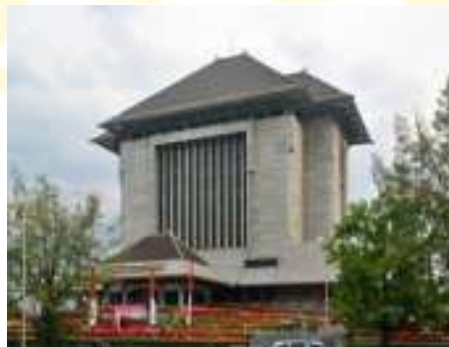
Gambar 2.11 Gedung Bank Indonesia BI Semarang ( Sumber: Ellya, 2015)
