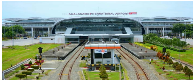
Gambar 2.8 Bandar Udara Kualanamu
